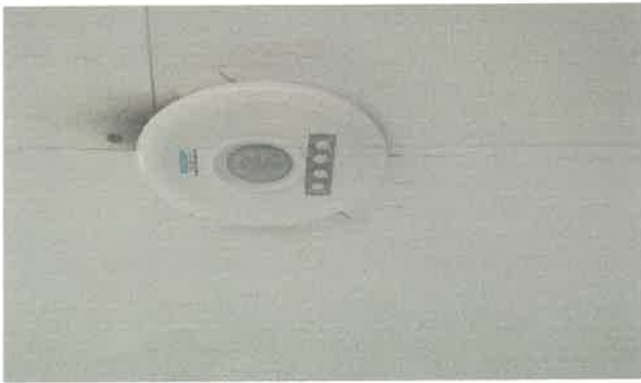
1층 남자화장실 센서감지기 교체
