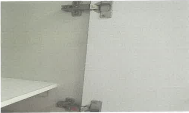
수영장 여자샤워실 락커문짝 보수
