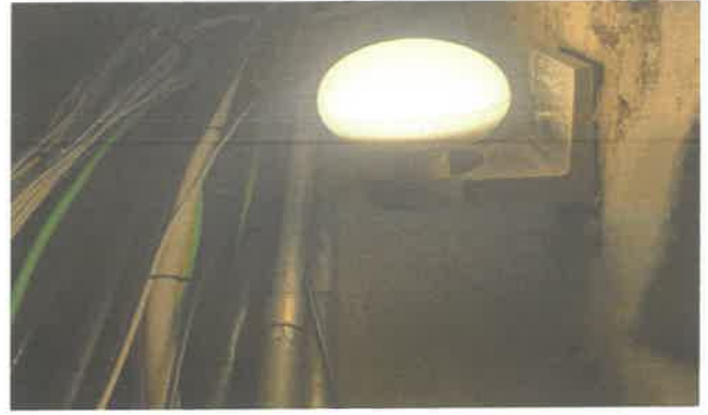
1층 전기분전반 비트 내 전구 교체
