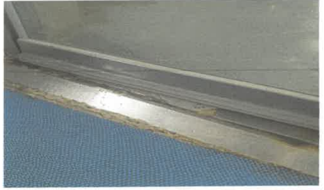
수영장 남자샤워실 출입문 H바 안전리브 재부착
