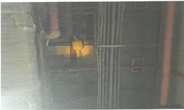
기계실 입구 천장 배관누수 물받이 설치
