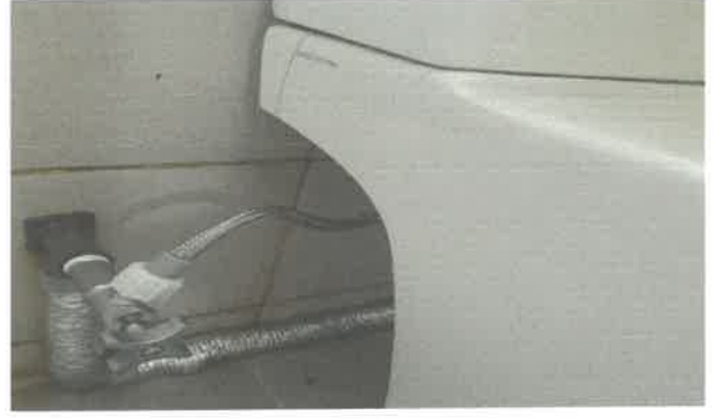
수영장 여자샤워실 내부 변기 후렉시블 교체
